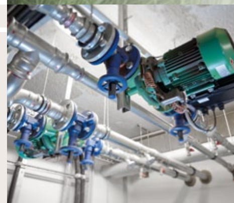
Über TRUMPF Universalkühlschnittstellen docken bei Seeger drei TruLaser Maschinen an das hauseigene Klimasystem an. Die Schaltschränke der Anlagen sitzen platzsparend auf Podesten (Bild unten rechts).
