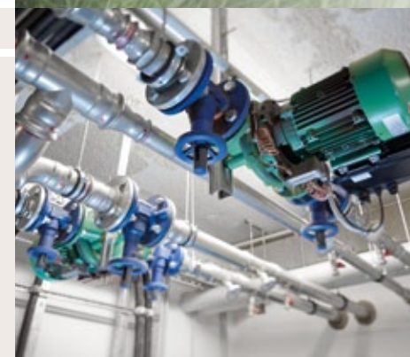
Über TRUMPF Universalkühlschnittstellen docken bei Seeger drei TruLaser Maschinen an das hauseigene Klimasystem an. Die Schaltschränke der Anlagen sitzen platzsparend auf Podesten (Bild unten rechts).
